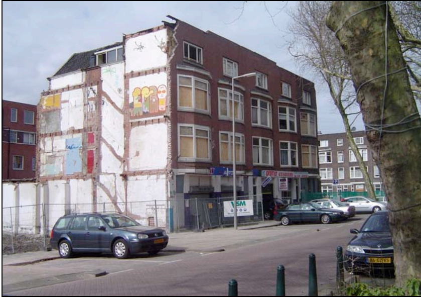
Afbeelding 3: Een deel van de vervallen bebouwing is inmiddels gesloopt.
