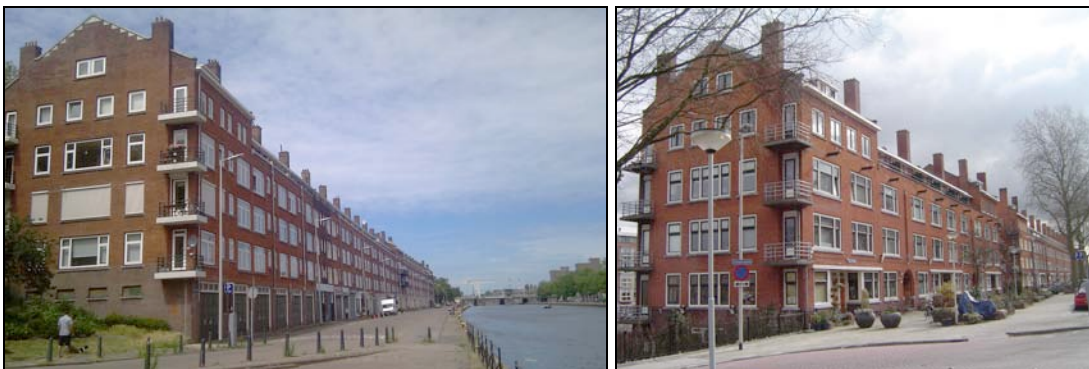
Afbeelding 2: Bebouwing langs de Spangesekade en de Mathenesserdijk.
