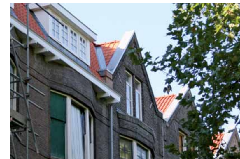
De daken zijn al vernieuwd
