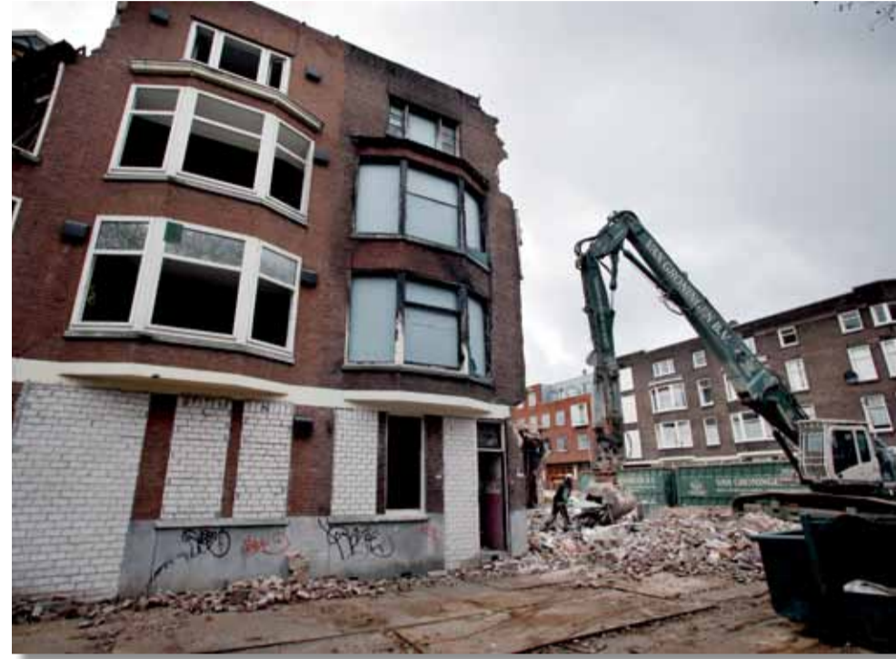
Sloop van de panden in december 2009
