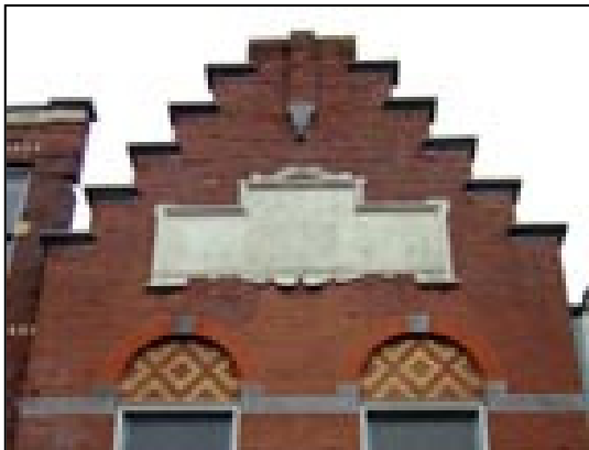
Detail gevel aan de Mathenesserdijk
