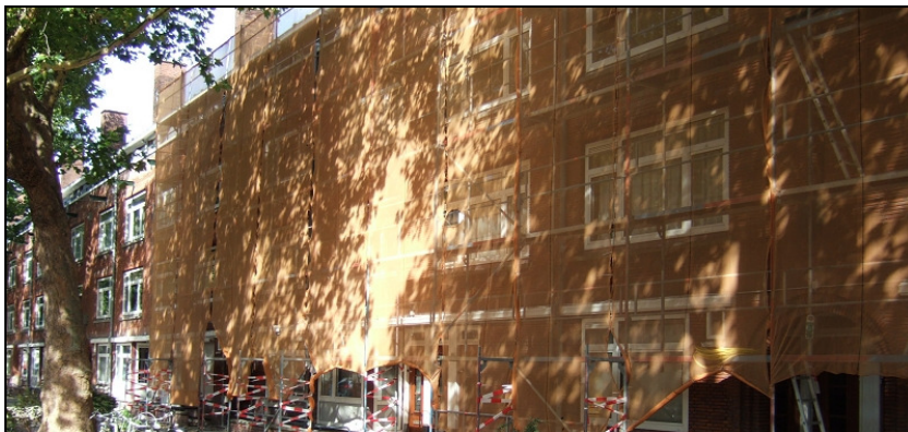
Schiezicht in de steigers.
