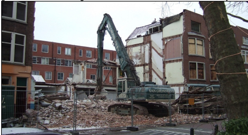
Sloop van het middenstuk in volle gang. Inmiddels ligt ook dat nu plat.
