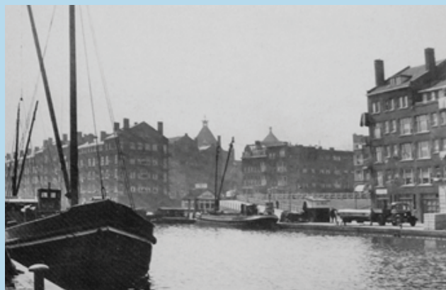
De Spangesekade, gezien vanaf de Aelbrechtskade, grofweg in dezelfde tijd. Hier is goed te zien hoe de opgang naar de Mathenesserdijk tussen de twee woonblokken was ingericht en hoe de pakhuisruimtes aan de kade gebruikt werden.
