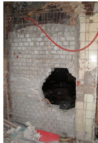
2.1: zuidelijke buitenmuur: deur
