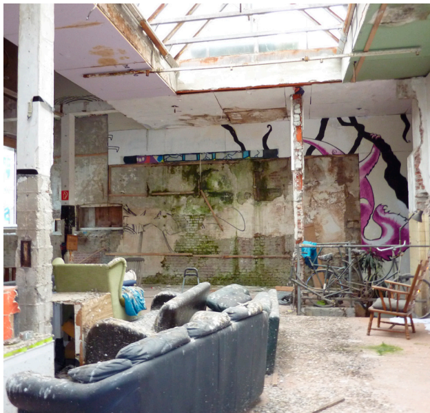
1.3: ruimte, zicht op buitenmuur 1.2
