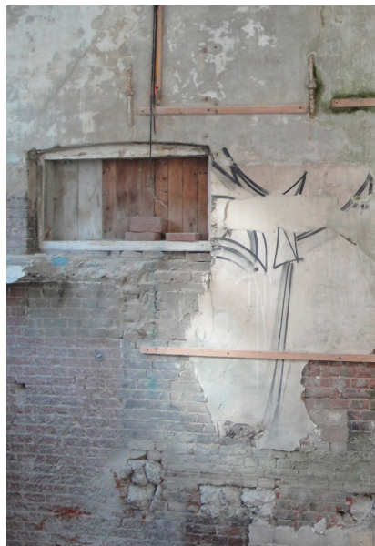
2.1: zuidelijke buitenmuur: raam
