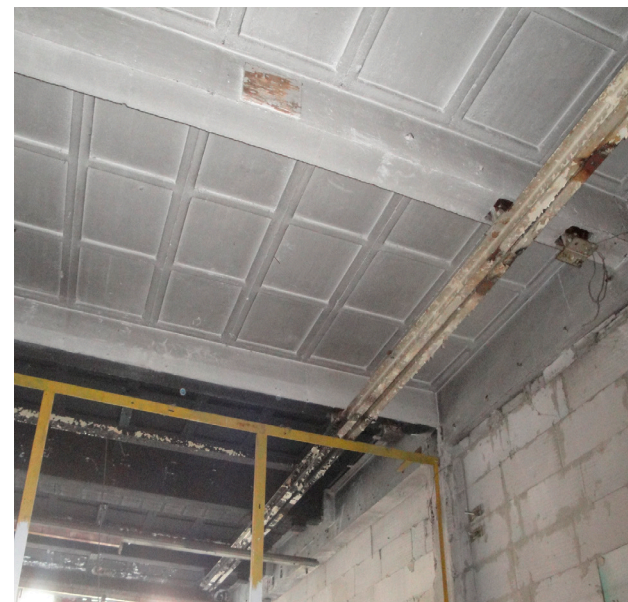
3.1 plafondconstructie met transportbaan
