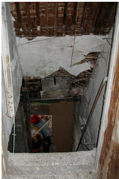
1.2: trap tussen begane grond en eerste verdieping
