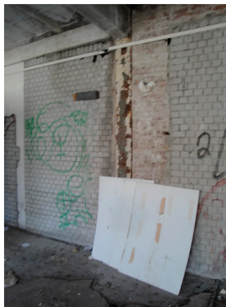
Restant buitenmuren 3.2 en 3.3, verbonden met 3.1
