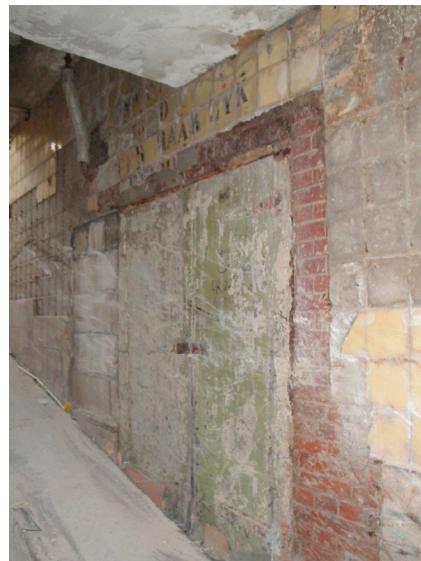
Buitenmuur met authentieke deur van 2.1
