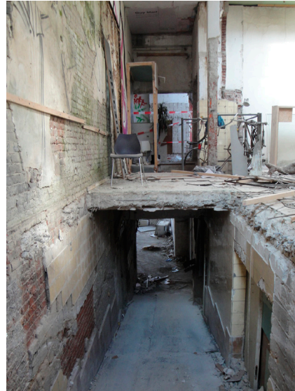
Gang van Mathenesserdijk met hellingbaan naar souterrain, links buitenmuur 2.1
