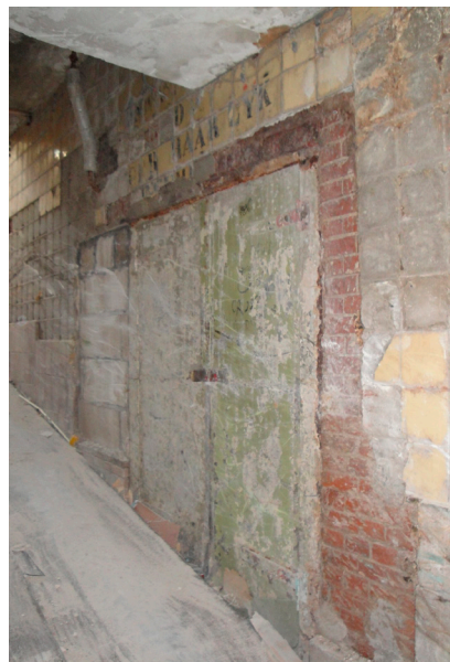
2.1: zuidelijke buitenmuur: deur
