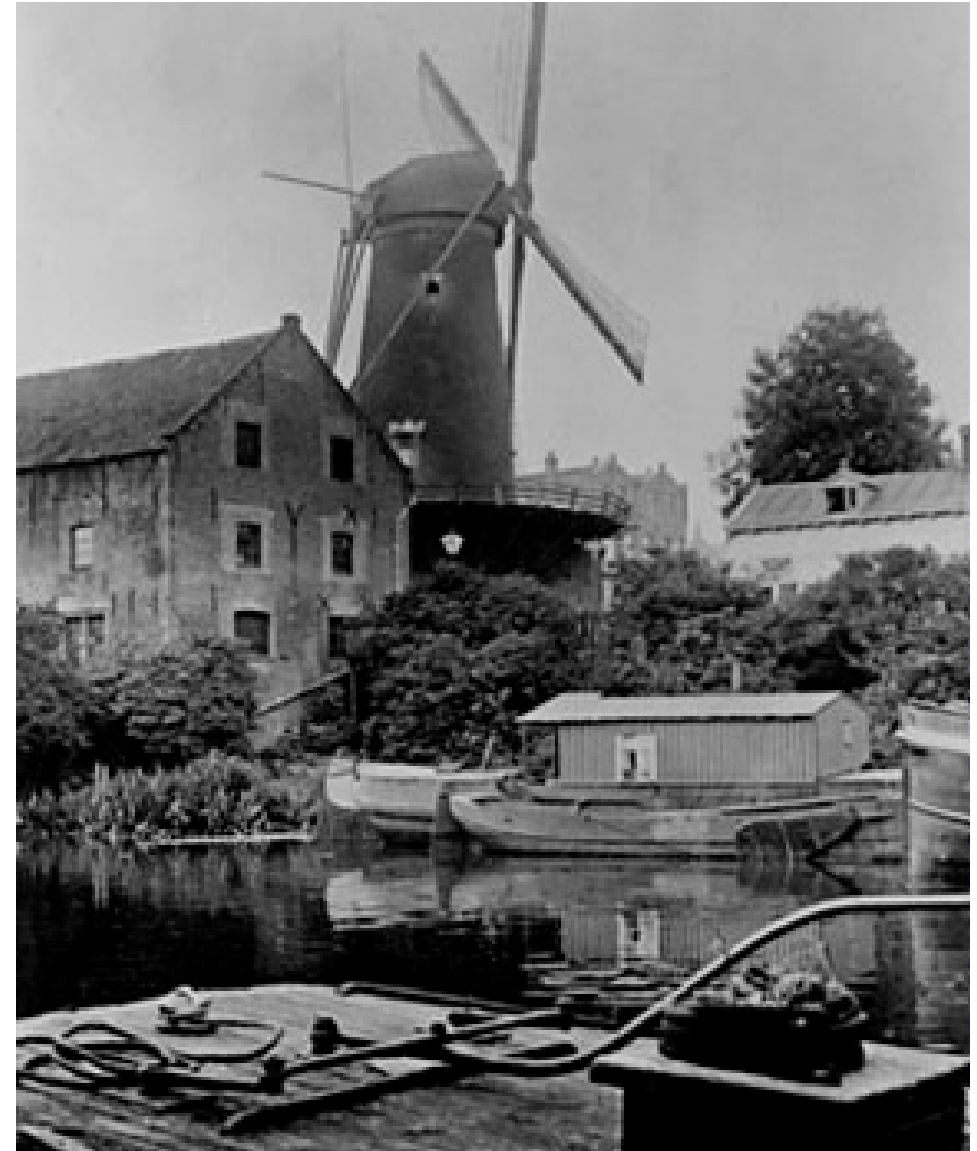
Zicht vanaf de Schie op de Graankorrel. Ervoor staat een fabriekspand die wat betreft vorm en typologie sterk overeenkomt met de verderop gelegen branderij. [GAR]
