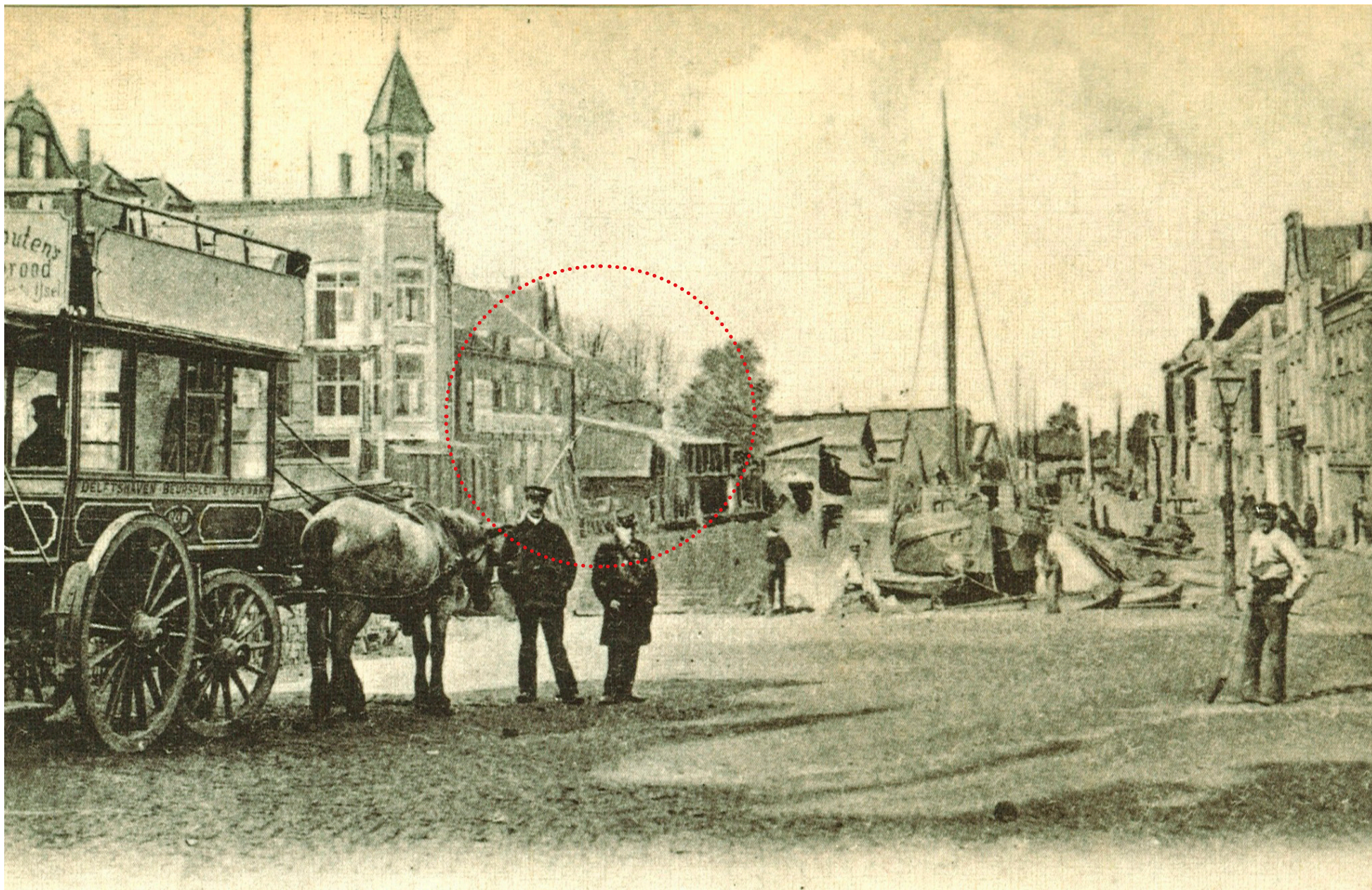
Ansicht uit 1904, nog voor de bouw van de schoorsteen. Goed te zien is de lage, industriële bebouwing langs de Schie, ten noorden van de branderij. [Okkema 1977, voorzijde]
